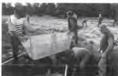
Pose d'un barrage-seuil en planches de bois
