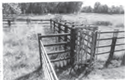
Un parc de contention à fort gabarit, idéal pour bovins et équins, Marais du Grand Hazé (Orne).
