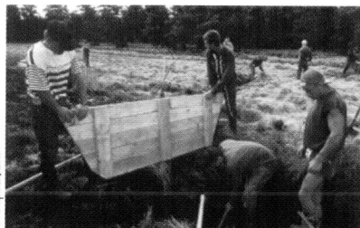
Pose d'un barrage-seuil en planches de bois
