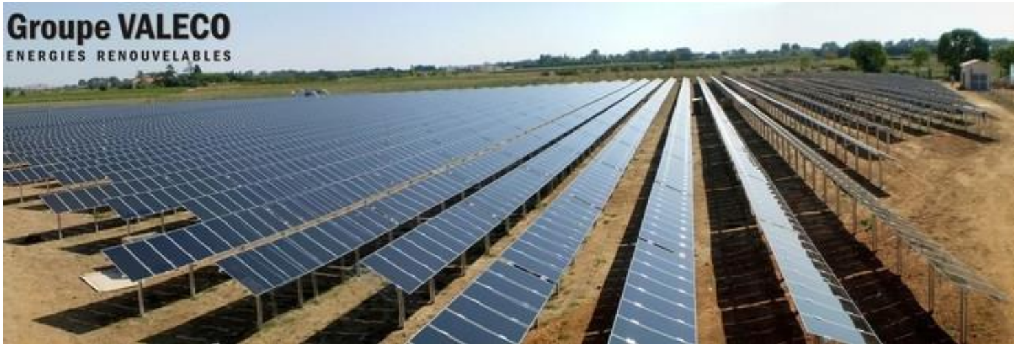
Figure 1 : Panneaux solaires, centrale de Lunel, Valeco, 2005
