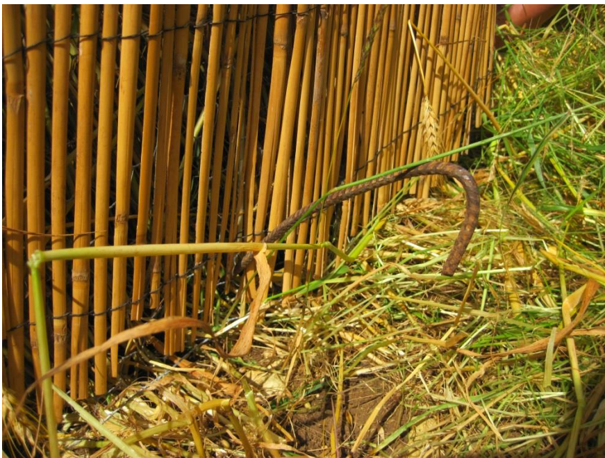
Figure 21 : Fixation du grillage à canisses à l'aide de sardines en fer à béton ( Moureau, 2013 )
