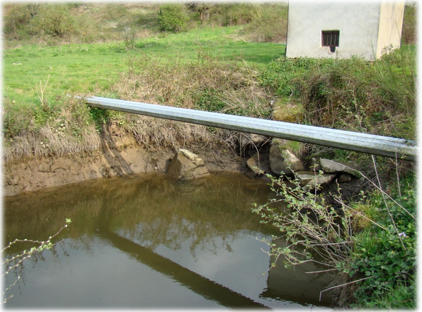
Illustration 26 : Canal d'irrigation de M. DEBOEUF
