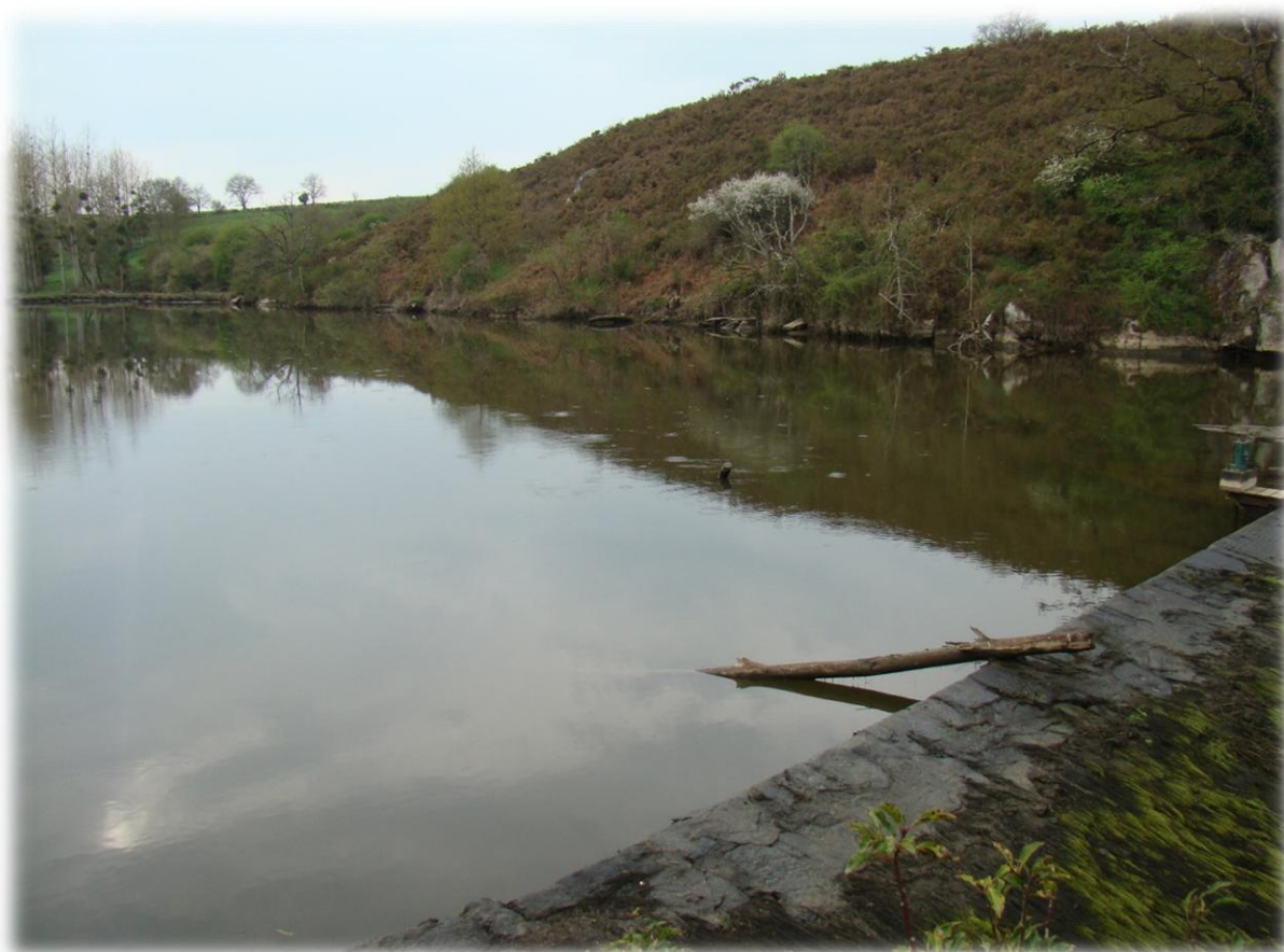
Illustration 22 : Retenue d'eau de l'ouvrage
