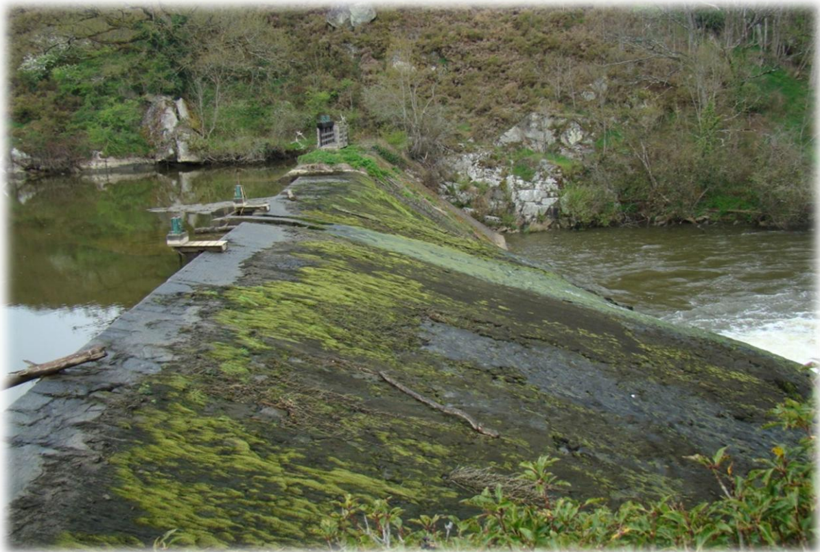
Illustration 14 : Barrage de la Forge à Fer
