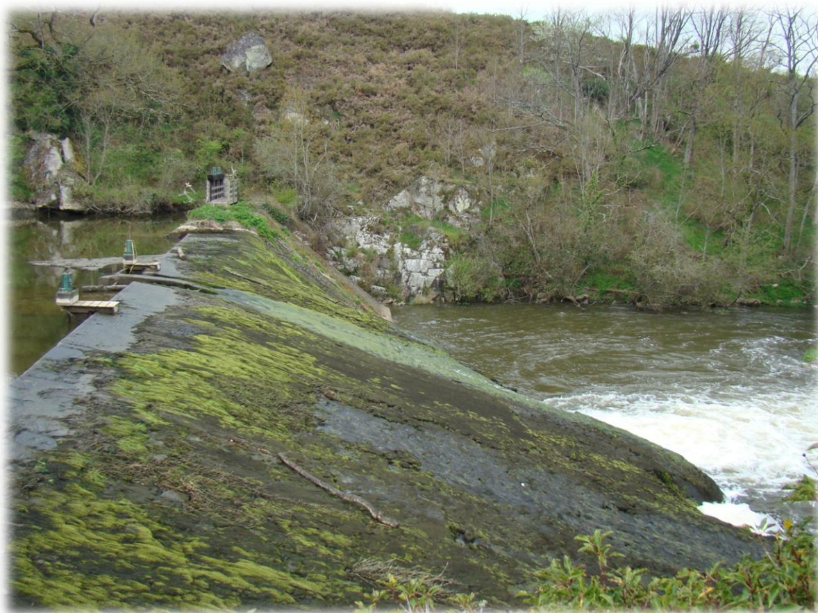
Illustration 21 : Barrage de la Forge à Fer
