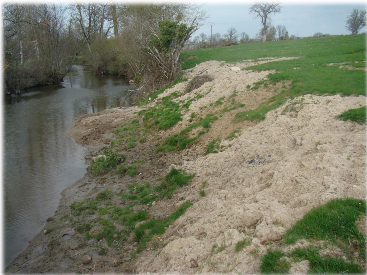
Illustration 25 : Dégradation du lit mineur et des berges par le piétinement bovins
