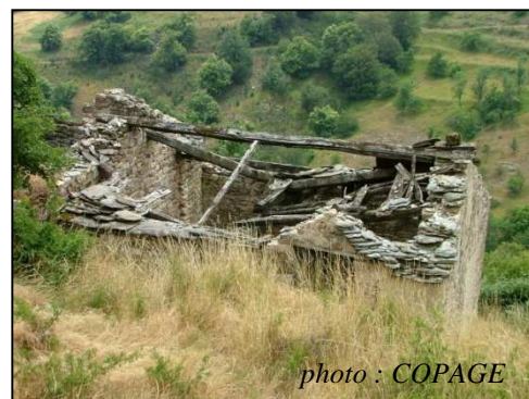
Figure 22 : GP de la Loubière - Cabane de Peyrastre avant rénovation
