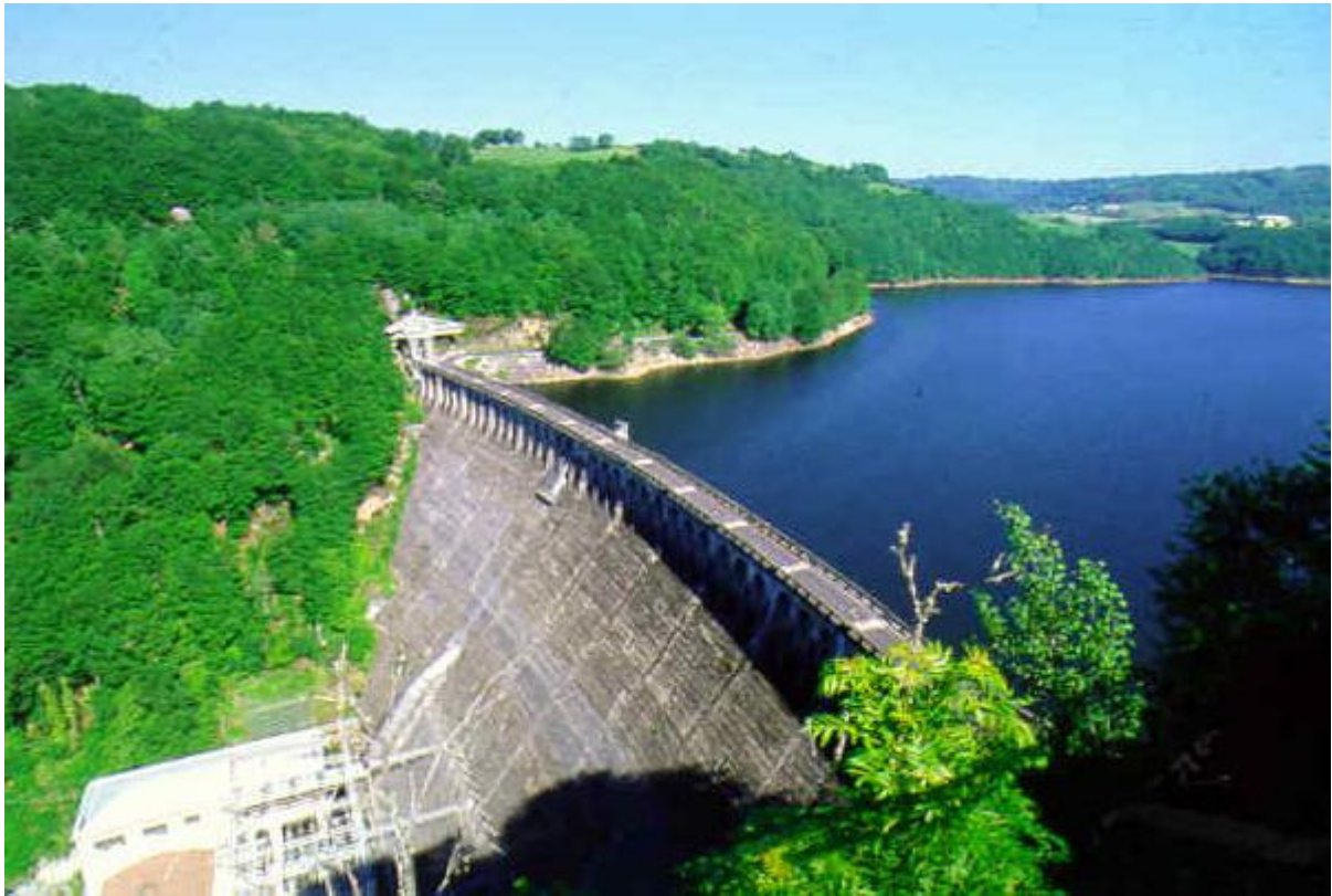
Figure 7 : Le barrage hydroélectrique de Sarrans – Aveyron ( http://hotel-lion-or.com/aveyron/barrages-hydroelectriques-edf-truyere/ )
