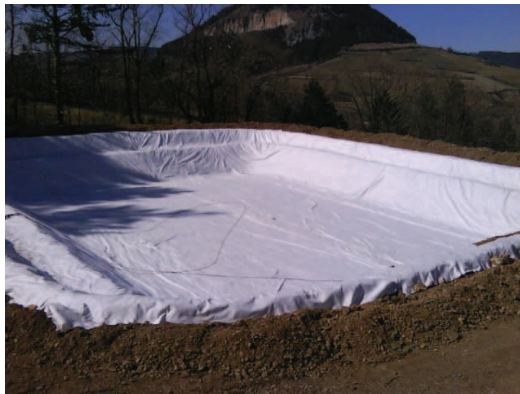
Illustration 8: Pause d'une géomembrane pour étanchéifier un réservoir (ASTAF 2011)
