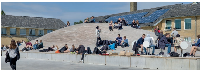
Lycée Gammel Hellerup, Copenhague Le toit du gymnase enterré devient élément paysager à escalader, BIG architects © Jens Lindhe Nyhavn
