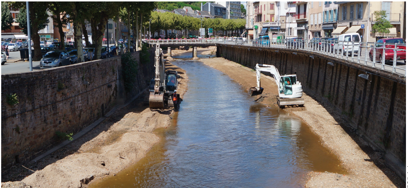
Destruction des seuils dans le centre de Tulle et pistes de chantier pour la circulation temporaire des engins.
