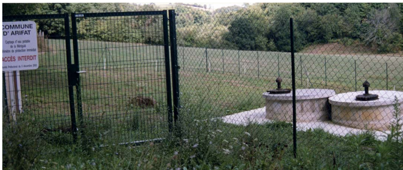
Périmètre de protection d'un captage d'eau potable d'une commune rurale
