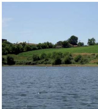
Barrage de La Touche Poupert (79)
