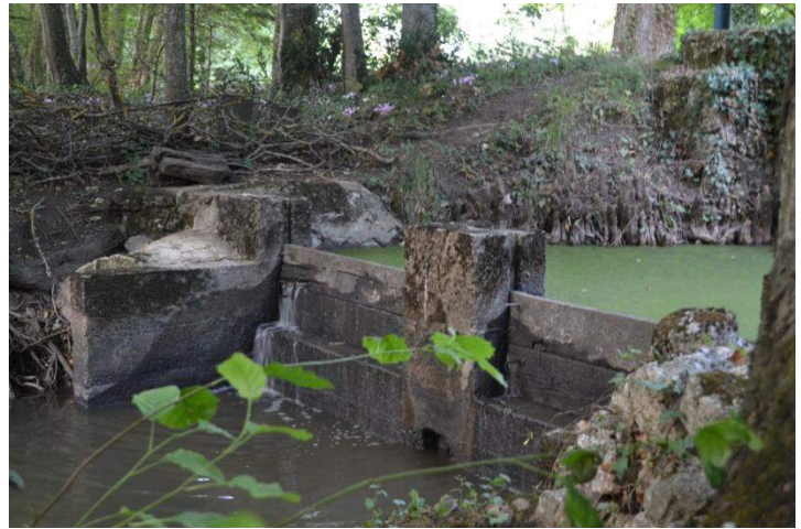
Figure 16 : Seuil aval de l'Ardoux Source: J.Malnoury, 2015
