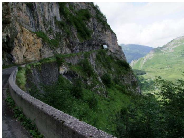
Figure 6 : le tunnel du Litor en 2014 (photo : Stéphane Gazel/CBNPMP)
