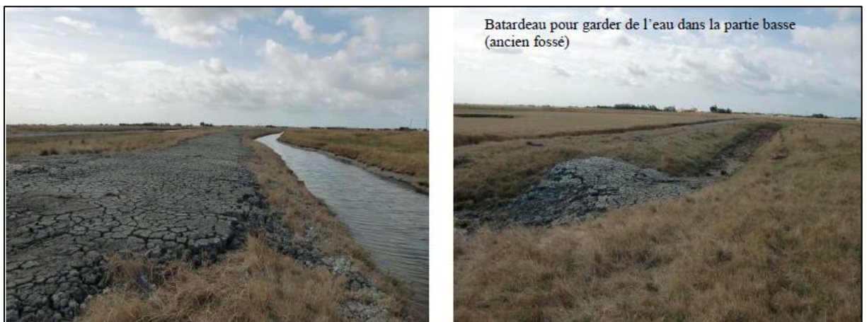
A gauche , régilage des boues de curage à droite , réalisation d'un batardeau avec les boues de curage pour maintenir l'eau dans les baisses (ADBVB)B)
