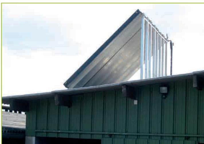
Photo 20 : Panneau solaire thermique installé sur une laiterie
