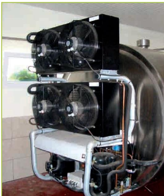
Photo 13 : La chaleur dégagée par le groupe froid peut servir au chauffage de l'eau
