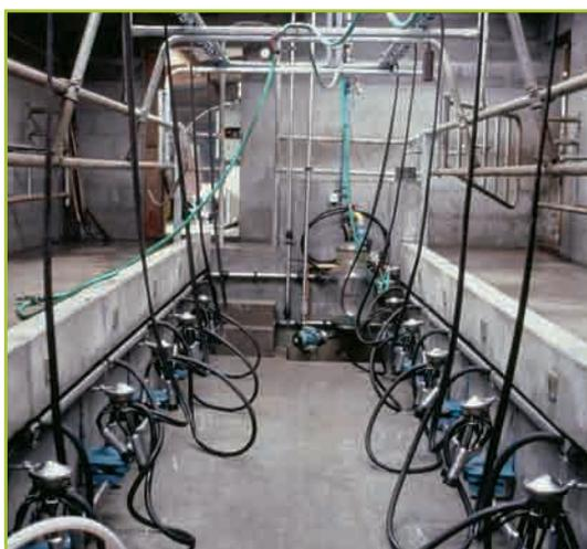
Photo 2 : Le bloc traite représente une consommation de 400 kWh/VL/an
