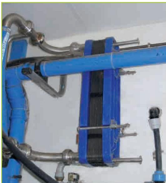
Photo 10 : Le pré-refroidisseur à plaques nécessite un entretien régulier
