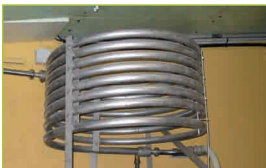
Photo 11 : Le pré-refroidisseur tubulaire représente un encombrement important
