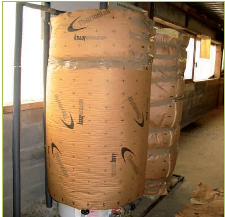
Photo 12 : Ballon de stockage de l'eau pré-chauffée couplé au chauffe-eau
