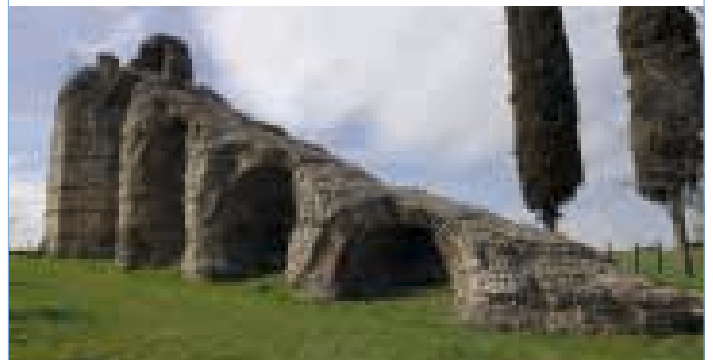
Départ du siphon de Beaunant
