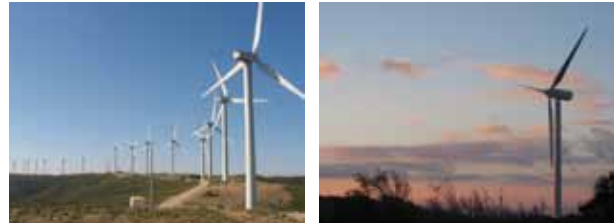
Centrale éolienne de Roussas et Donzère dans la Drôme Source : Ceder
