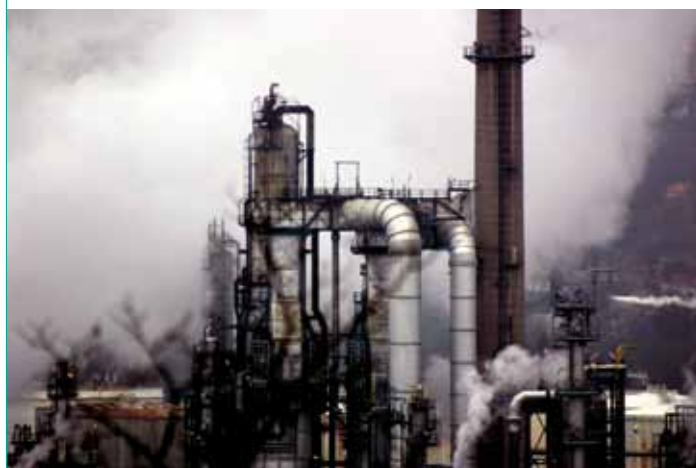
Raffinerie de Feyzin - Source : Ville de Feyzin
