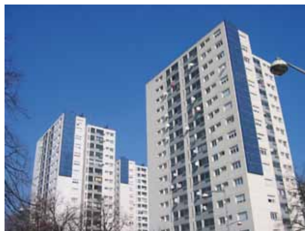
Centrale photovoltaïque sur des tours de la Darnaise à Vénissieux Source ALE Lyon
