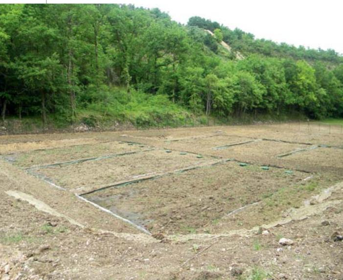
Des relevés topographiques ont été réalisés afin de déterminer les possibilités d'implantation de l'unité de traitement des eaux usées. La zone, d'une superficie de 3 137 m<sup>2</sup>, présente une pente faible comprise entre 2 et 5 % et une épaisseur de 0,40 m de terre végétale.
